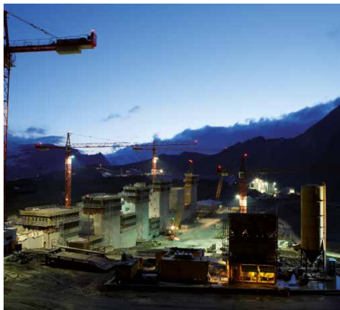
Pumpspeicherkraftwerk Linth-Limmern, Arbeiten an der Staumauer
