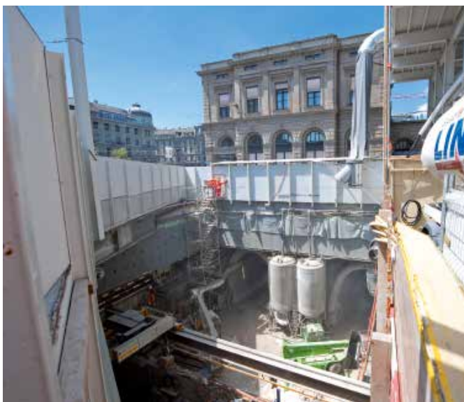
Schacht Südtrakt: Längsstollen zur Unterquerung des historischen Südtraktes
